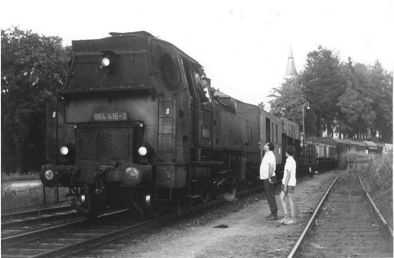
Abb. 6, oben: Inzwischen ist der beachtlich lange 16196 fertig zusammengestellt, die Luftpumpe arbeitet noch, die vereinfachte Bremsprobe wird gleich gemacht (31.07.72, Pleystein). Mein Freund (in Begleitung seines Filius) beschwätzt gerade den älteren Lokführer, mich auf dem Führerstand bis Vohenstrauß mitzunehmen. Die Dämmerung ist inzwischen schon fortgeschritten, die Laternen der Lok daher bereits eingeschaltet. Rechts das Gleis des Holzlagerplatzes. Man entschuldige die Qualität des Fotos.
