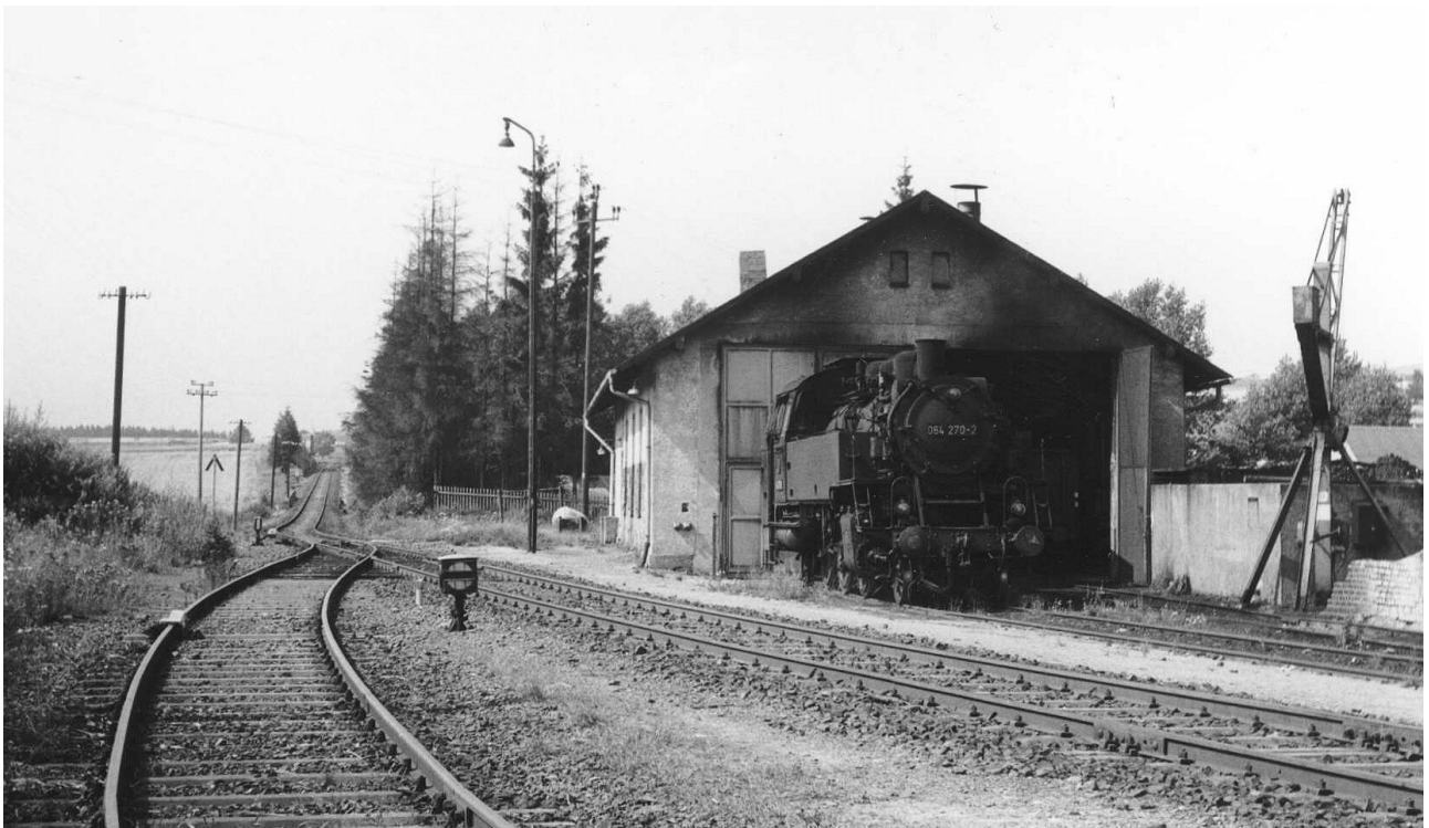
Abb. 12, oben: Dieses Foto wurde ausgewählt, da es das Gefälle der Strecke in den Bahnhof Eslarn zeigt. Wie dies zum Umsetzen genutzt wurde, kann man im Text nachlesen. Die 64 270 hatte in der Früh den Ng 16185 nach Eslarn gebracht und wartet vor dem Maschinenhaus auf die Rückleistung nach Weiden (Ng 16196). Die Loks der Güterzüge fuhrten nach Eslarn, wie erwähnt, vorwärts. Rechts Kohlenbansen und Kohlenkran. Die Lokomotiven der Personenzüge mussten zum Teil durch das rechte Tor in das Maschinenhaus fahren, um bekohlt werden zu können. Leider hat das der Autor nur gefilmt, nicht fotografiert (01.08.72).
